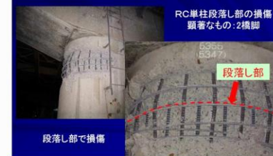
国道8号 新組跨線橋下り線(長岡市)
