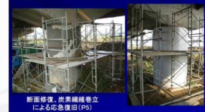
国道8号 新組跨線橋下り線(長岡市)
